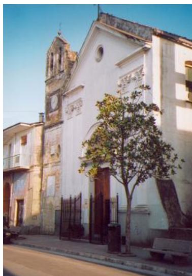
Fig. 1 - Facciata della Chiesa di Casolla.
