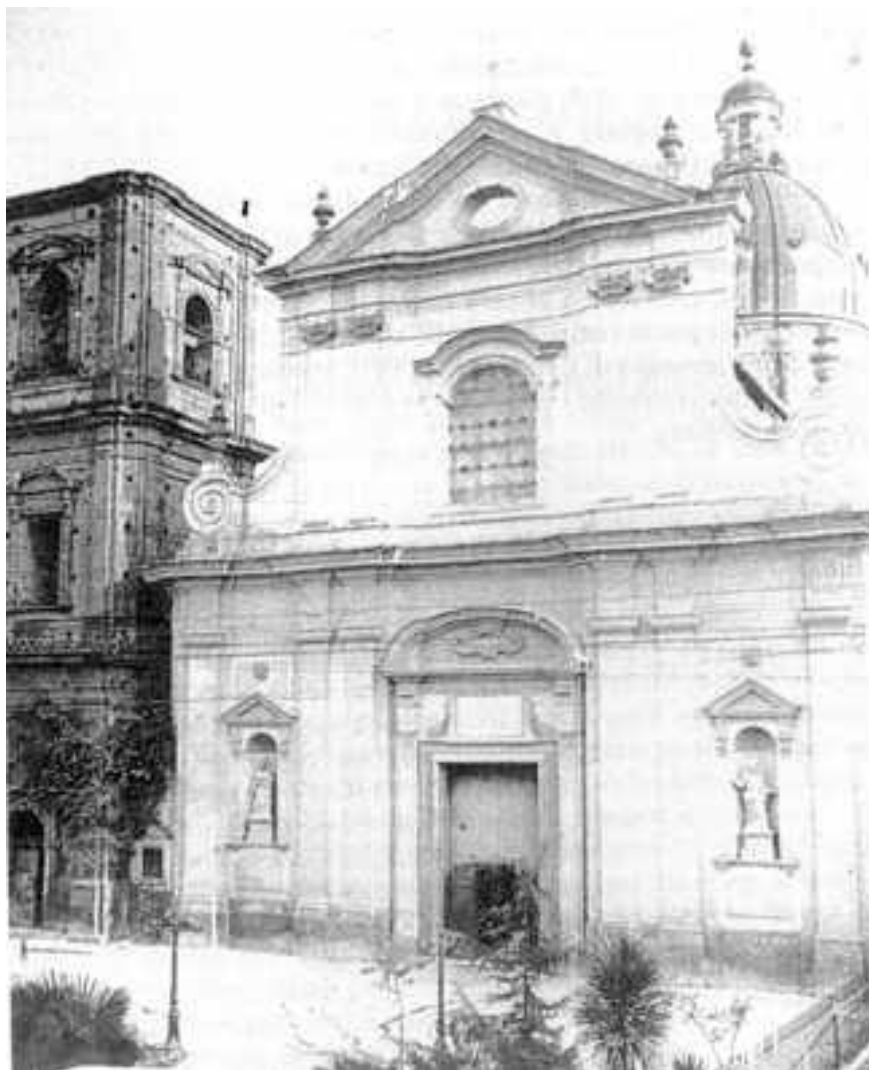
Fig. 1 - La facciata della basilica di San Tammaro di Grumo Nevano da una foto degli anni '30 circa (Archivio fotografico della ditta Discorama di Grumo Nevano).
